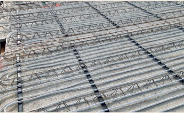
Aktiviere Betonplattendecke: Heiz-/Kühlrohre werden mittels Kunststoffschiene auf die Plattendecke befestigt.
