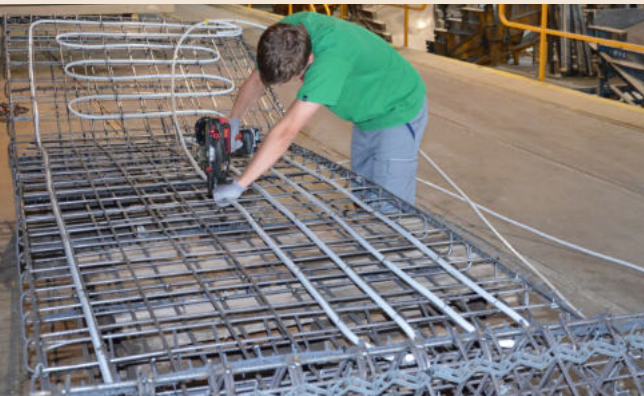
Aktiviere Stiegenheizung/-kühlung: Heiz-/Kühlrohre werden noch vor der Fertigstellung der Stiege auf die Bewehrung befestigt.
